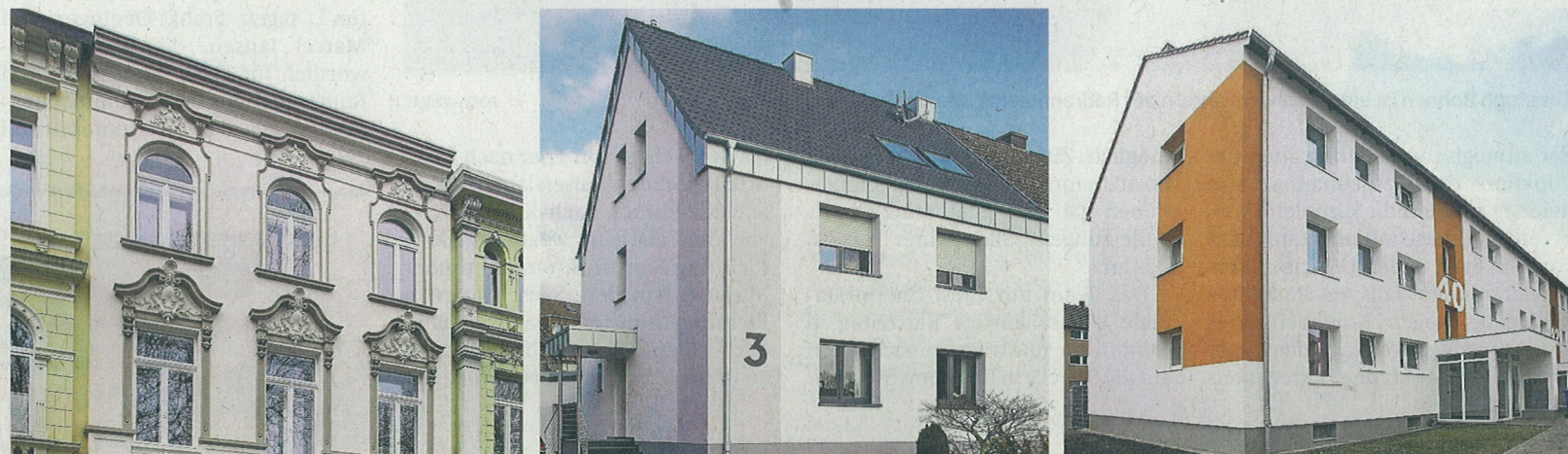
Von links nach rechts: Die Gewinner-Fassaden in den Kategorien Wohnhäuser mit Stuck (Hohenzollernstraße 58), Wohnhäuser ohne Stuck (Stähn 3) sowie Wohnsiedlungen (An der Holter Heide 40/42).
